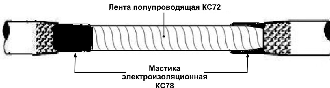
3.8.1 Намотайте вокруг жил в два слоя полупроводящую ленту КС72 с половинным перекрытием, начиная и заканчивая намотку на внутренней полупроводящей оболочке.
