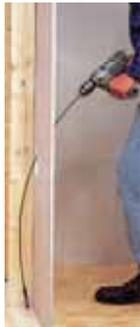
Гибкие сверла позволяют заготавливать кабельные каналы во внутренних перегородках и каркасе полых стен, потолка или пола без демонтажа облицовки. Угловая направляющая помогает точно задать направление сверления в скрытых полостях на расстоянии до 180 см от имеющихся технологических отверстий (розеточных, вентиляционных). При помощи гибкого сверла можно вытянуть кабель в заготовленный канал, закрепив его при помощи кабельного чулка (стр. 95) к специальному отверстию на конце сверла.
