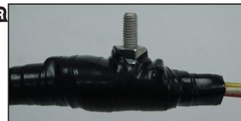
**5.5** Установить верхнюю часть соединителя и закрепить гайкой. Наложить на соединитель и на прилегающие к нему участки ОК биндаж из двух-трех слоев ленты ПВХ на длине около 10 мм.
