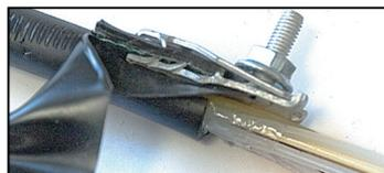
**4.3** Установить нижнюю часть (основание) соединителя Scotchlok 4460-D (далее – соединитель) под отогнутый участок оболочки, поверх ленты ПВХ. Установить верхнюю часть соединителя на шпильку основания и обе части стянуть одной гайкой.
