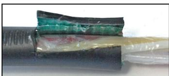
**4.1** Сделать на полиэтиленовой оболочке совместно со стальной гофрированной (алюминиевой) лентой продольный разрез на длине 25 мм от ее торца, а затем – круговой на 1/2 длины окружности. Отогнуть участок оболочки вместе с лентой. Обезжирить и зачистить внутреннюю поверхность ленты под этим участком оболочки ОК.
