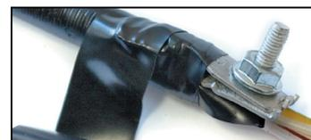
**4.4** Закрепить на ОК соединитель биндом из 2-3 слоев ленты ПВХ с 50 % перекрытием.
