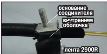
**5.3** Ввести нижнюю часть соединителя между внутренней оболочкой с наложенной на нее лентой 2900R и наружной оболочкой, под стальную гофрированную ленту.
