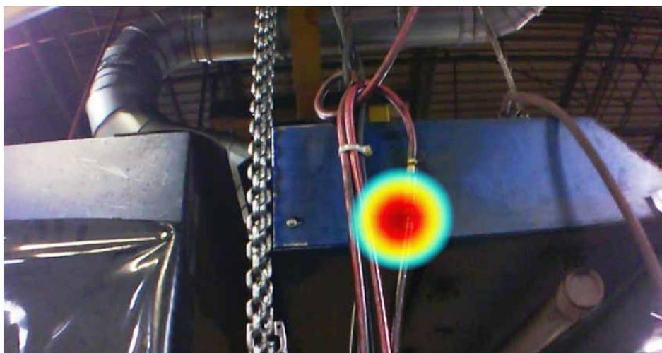
Снимок сделан акустическим устройством визуализации для промышленного использования ii900 при обнаружении воздушной течи в промышленном здании.
