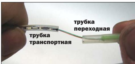
**14.2.3.4** Промаркировать самоклеющимся маркером транспортную трубку, надвинутую на ОМ, в соответствии с нумерацией этого ОМ.
