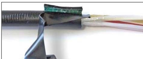
**8.1.4** Установить нижнюю часть (основание) соединителя Scotchlok 4460-D (далее – соединитель) под отогнутый участок оболочки, поверх ленты виниловой. Установить верхнюю часть соединителя на шпильку основания и обе части стянуть одной гайкой.
