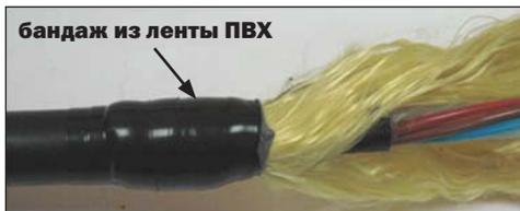
**8.3.4** Продвинуть ОК в патрубок и расположить ОК таким образом, чтобы обрез внутренней оболочки ОК выступал за край патрубка примерно на 5 мм.
