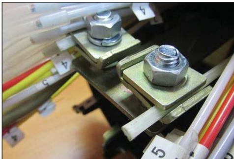
Примечание – Если ЦСЭ представляет собой стальной трос в полимерном покрытии, выполнить электрическое соединение этого ЦСЭ с броней ОК с помощью отрезка ленты-плетенки заземления или перемычки, подключив ленту-плетенку заземления/наконечник перемычки к шпильке узла крепления ЦСЭ (на кронштейне) и к шпильке соединителя Scotchlok 4460-D, установленного на ОК.
