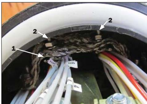
**1** – отрезок ленты-плетенки заземления (перемычка соединения брони ОК), соединяющий конструктивные элементы (броню) ОК, введенных в муфту;
