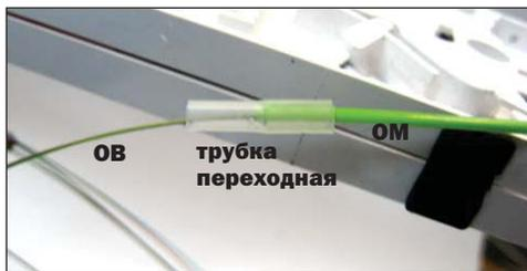
**14.2.3.3** Ввести пучок ОВ в отрезок транспортной трубки; осторожно продвинуть отрезок этой трубки к месту установки на ОМ переходной трубки и вставить в переходную трубку, до упора в торец ОМ.
