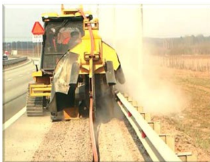
Рисунок 2 – Монтаж микро-траншей в асфальтном покрытии
