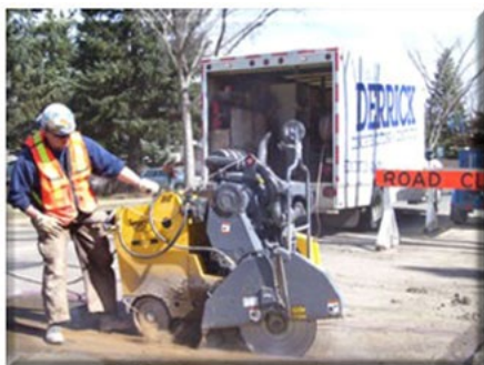
Рисунок 2 – Монтаж микро-траншей в асфальтном покрытии
