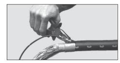
3 Подключить зажим провода соединения экрана к Г-образному надрезу оболочки.
